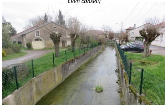
Exemples d'obstacles à l'écoulement des eaux : un ruisseau canalisé (source : Even conseil)
