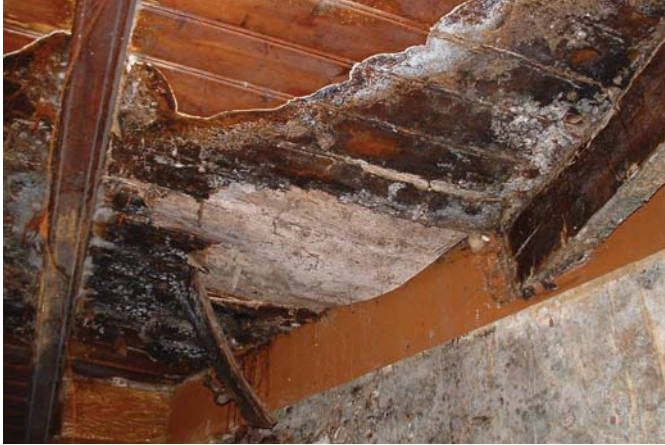
Attaque d'un plancher par la méréule http://expar.fr/parasites/champ_photos/merule/Merule_03b_6_mois_apres.JPG
