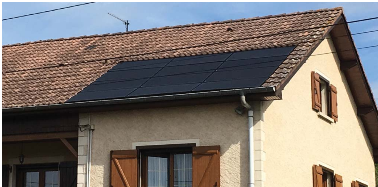
Panneaux solaires sur le toit d'une maison de village à GOVILLER
