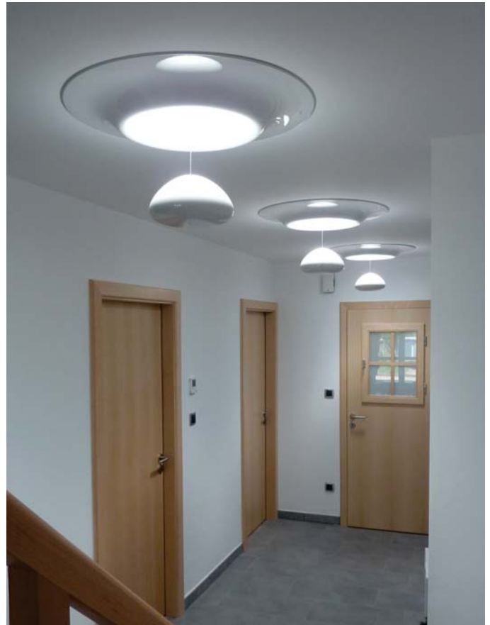
Conduits de lumière éclairant une maison à ST REMIMONT Photo de Cécile VAUBOURG et Michèle VIDAL
